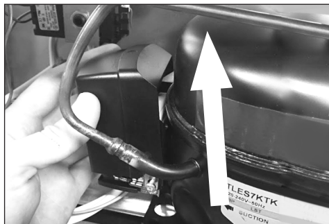
2. Levante la cubierta de plástico.
